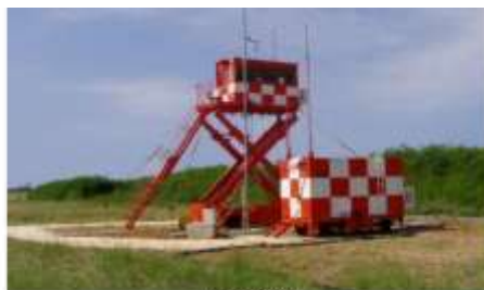
非常用管制塔設備
