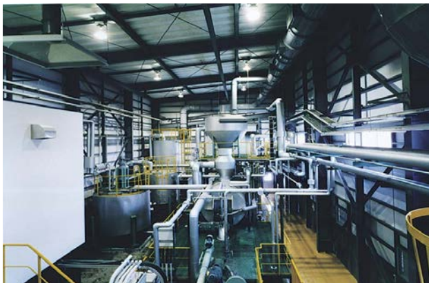
処理棟内部状況
